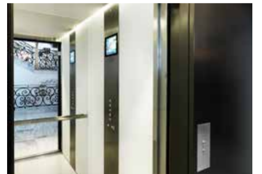
IBEROSTAR GRAND HOTEL MENCEY INTERIOR ELEVATOR ZARDOYA OTIS Location: Santa Cruz de Tenerife, Spain Designer: Corona, Amaral y Asociados SLU Realization: Carpintería Ramos e Hijos
